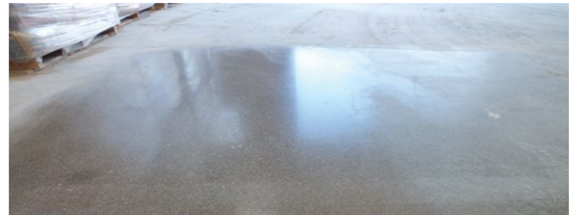
Odświeżanie starej posadzki betonowej
